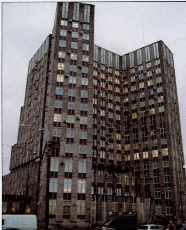
Фронтальная фотография участка фасада или крыши в месте предполагаемой установки объекта для размещения информации (удаленная)
